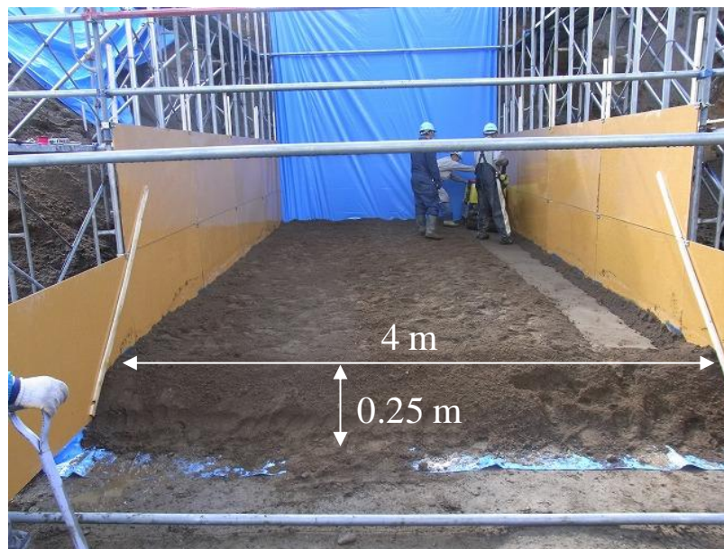
(d) Compacting Komaoka volcanic soil of 0.25 m per a compaction layer
