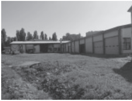
A. 調査前の状況(遠景:西より)
