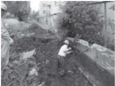
C. フェンス・擁壁修繕工事(南より)1905
