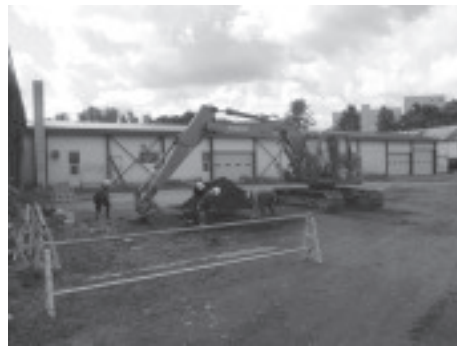
B. 掘削の様子(遠景:南東より)
