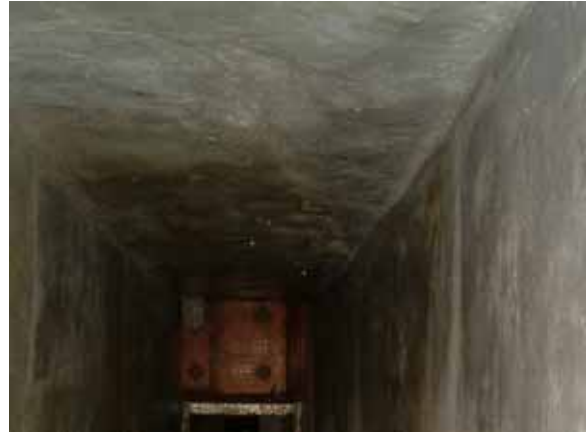
写真-2 耐硫酸モルタル施工後の流入水路 (写真-1と同じ場所)
