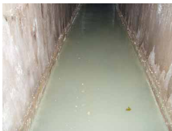
写真-4 施工後1年目の状況(M-2施工箇所)
