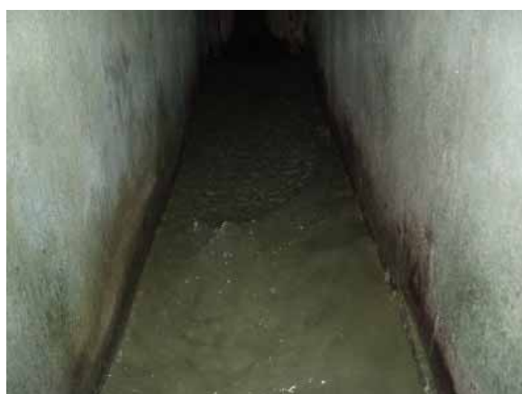
写真-3 施工後1年目の状況(M-1施工箇所)
