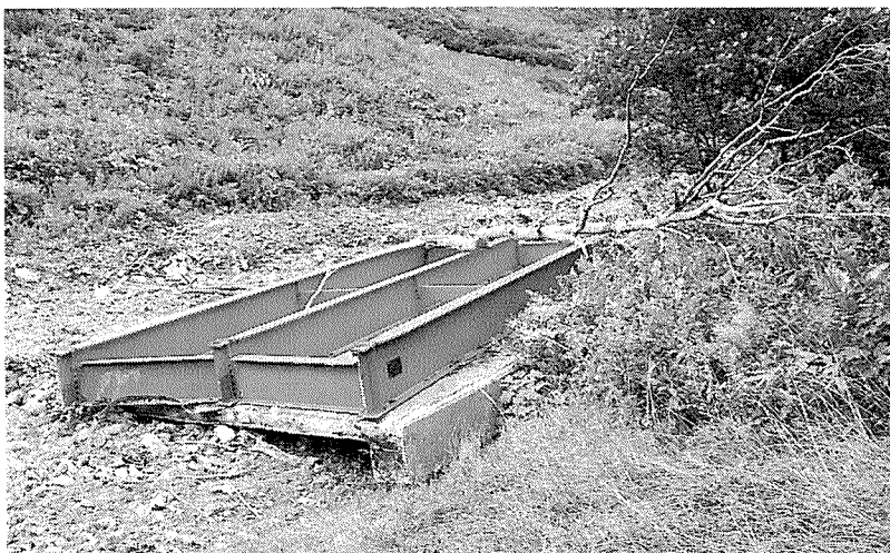
第4図 80m流された橋脚 橋は上下反転しその上に折れ木があるが土砂の堆積はない
