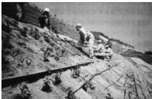
写真2 斜面地緑化施工中 (1996年)
