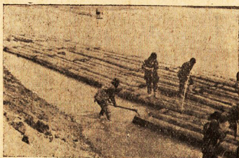
圖-78. 網羽水中架設作業 (1). 網羽用木材を河岸まで極積より曳き出し、 河岸にて網羽子をつくる (IV-15).
