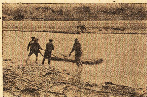
圖-80. 同 (3). 河岸から主索に渡してある渡船綱に網羽子 を引掛け水勢を利用して主索まで之を流し 込む、今突放さむとするところ (IV-15)
