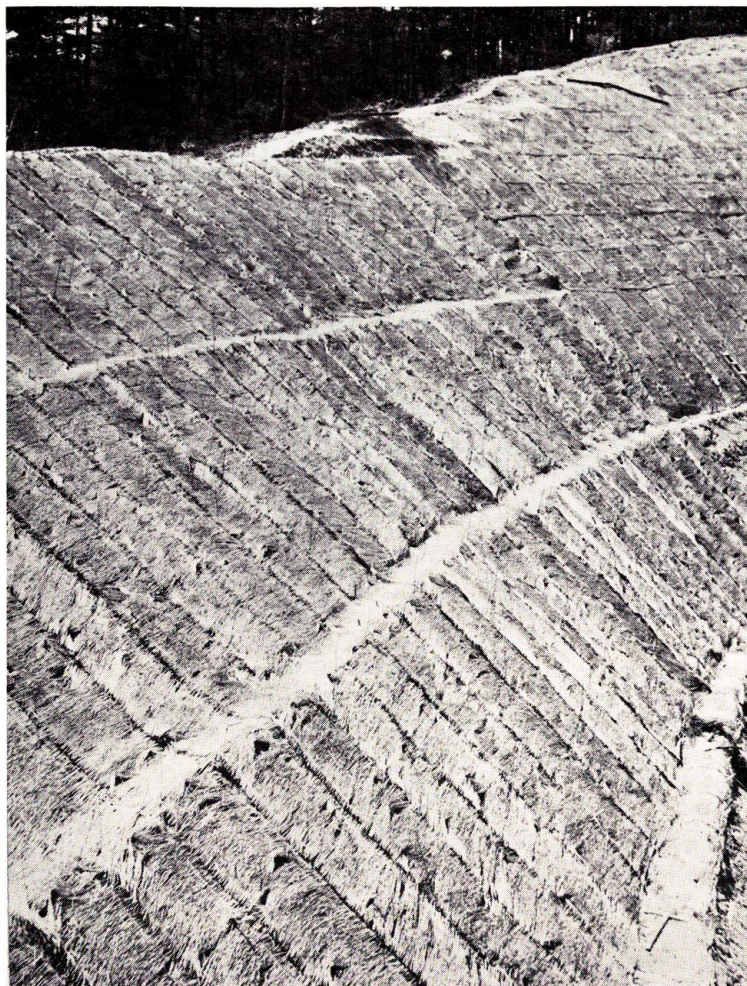
写真7 長野県東筑摩郡明科町大字七貴 むしろ張工 (1) (施行) 1956 地質洪積層 全面早期「緑化工」種子…ヨモギ, エノコログサ, 樹種…アカシヤ, イタチハギ 山腹工事として従来施行して来た積苗工・編柵工・水路工を全廃し 法面の早期緑化を主目的として施行した
