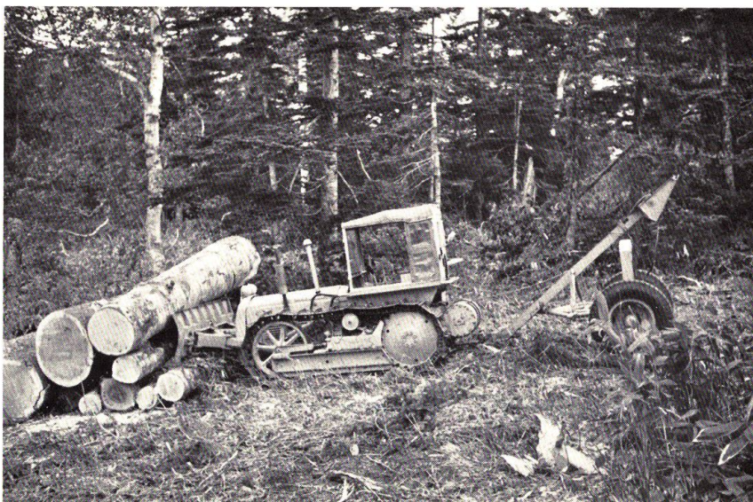
写真 16. 排土板による丸太樁積 (CD 50 型トラクター)
