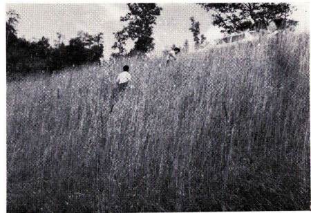
写真-2 導入植生による全面被覆 (盛土筋芝工, 4年経過)
