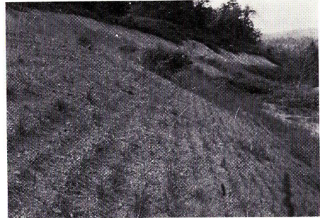
写真-1 盛土法面の筋芝工 (2年経過)
