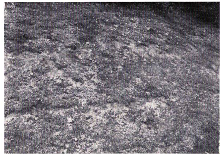
写真-5 吹き付け工導入植生の枯死とはく落 （4年経過）
