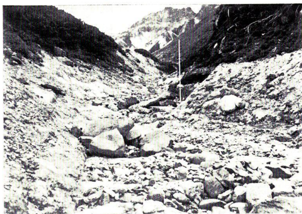
写真-4 洗掘による溪床低下 (S-R, line 10)
