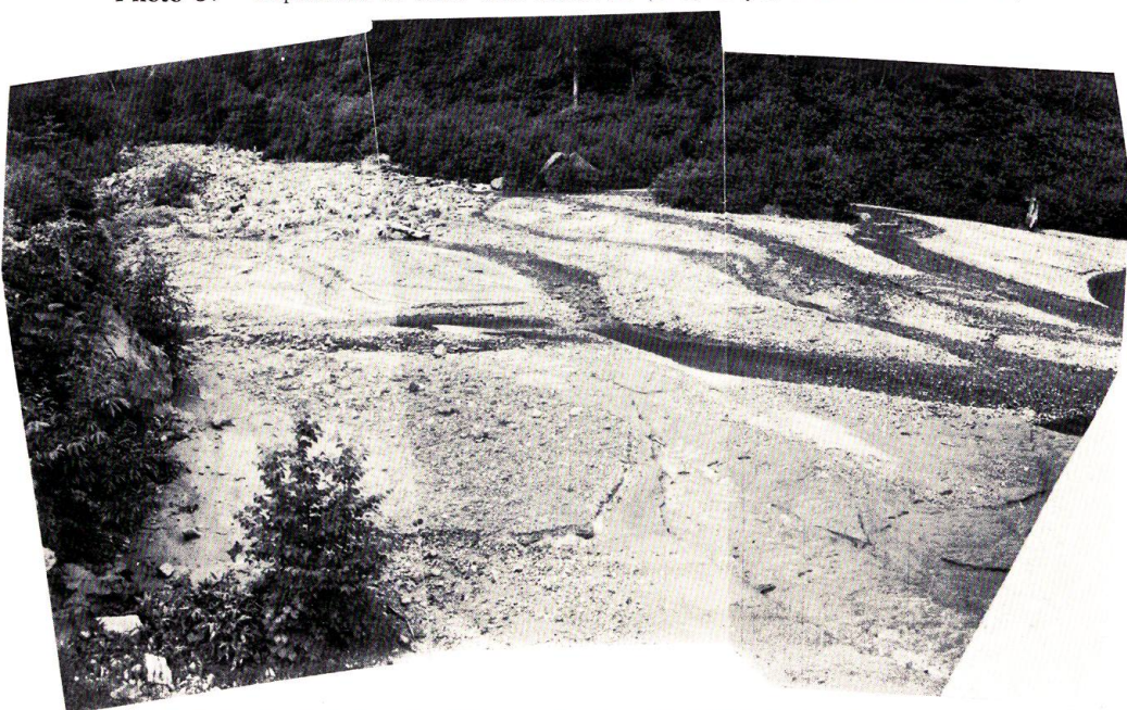
写真-6 砂防ダム堆砂状況 (D-4, 施工後9年) 堆砂面の区分が認められる
