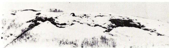
写真一15 同3 林班雪崩防止工施工以 前の状態 (冬期)
