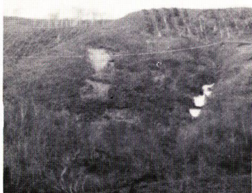
写真一21 1981，1984年無処理区に発生した崩壊地
