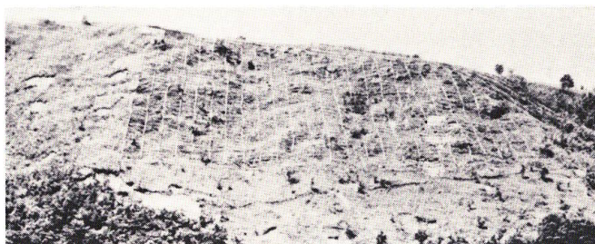
写真一17 丸太枠組工施工の状態 (1968年)
