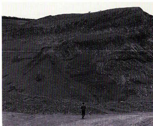
写真-2 Wk (稚内層) の露頭 右上から左下方向に少なくとも2本の顕著な破碎帯が認められる。破碎帯からは降雨時に水の湧出が認められ、左手の崖錐上部にその跡が確認できる。位置は図-2 参照。
