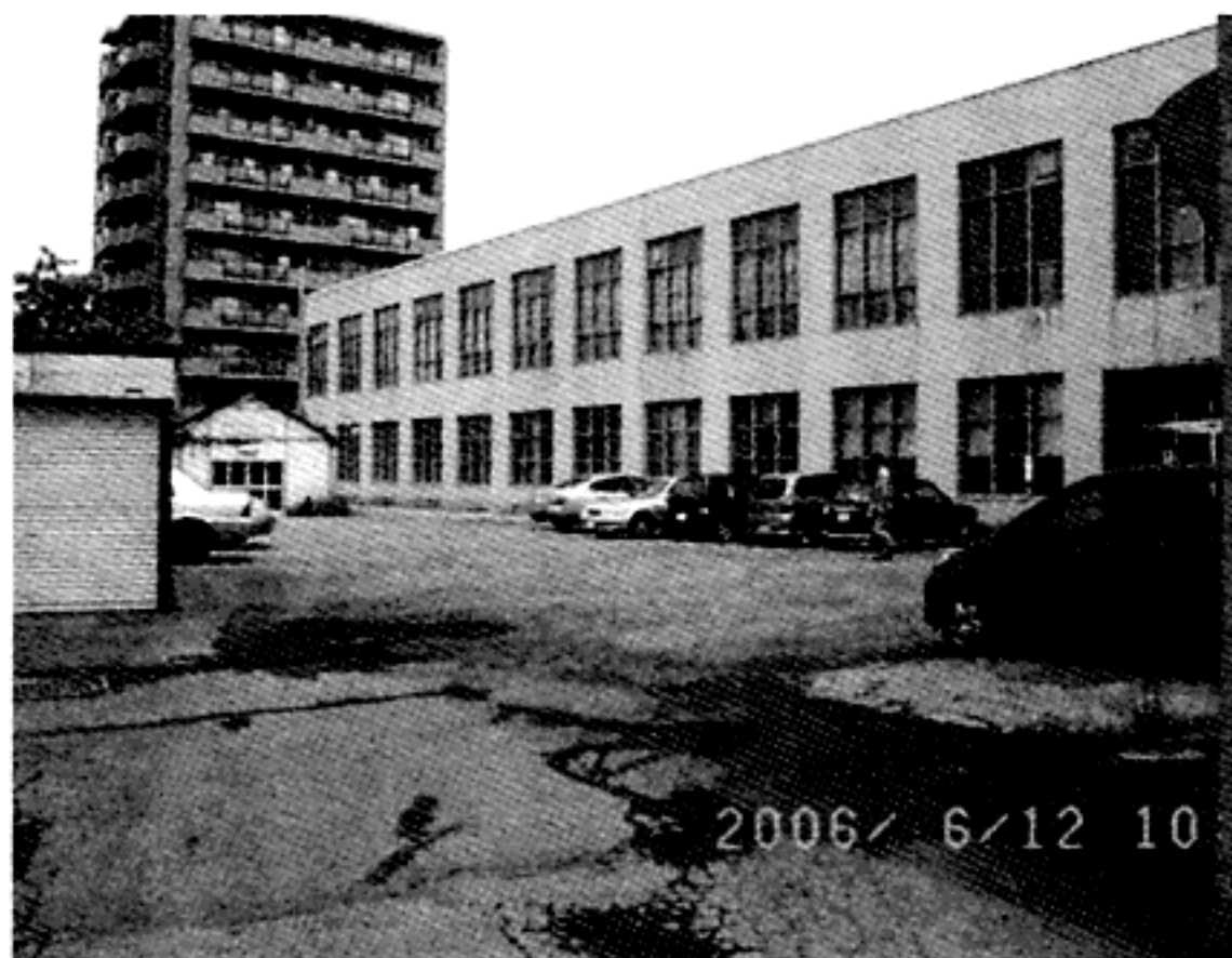
小樽文学館・美術館駐車場の現況
