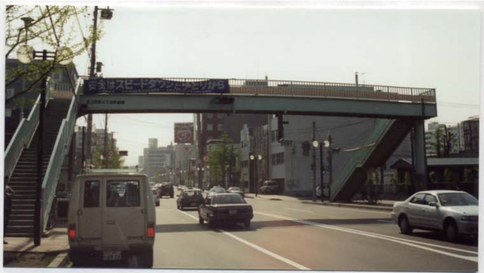
写真-5.4 北3条東4丁目歩道橋
