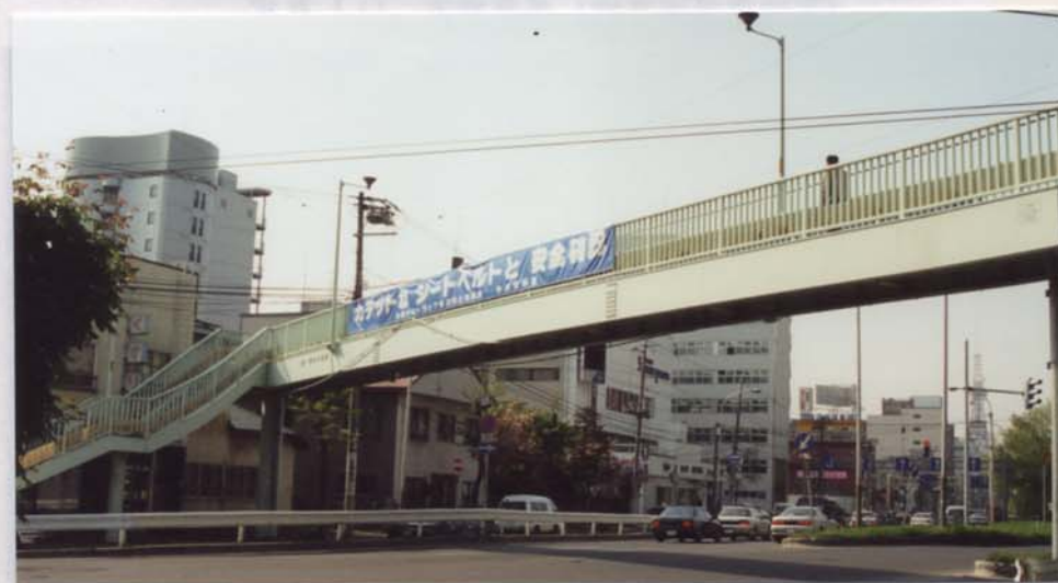
写真-5.9 豊水歩道橋
