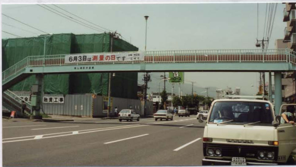
写真-5.7 東山歩道橋
