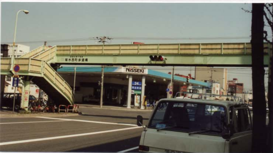
写真-5.6 菊水西町歩道橋
