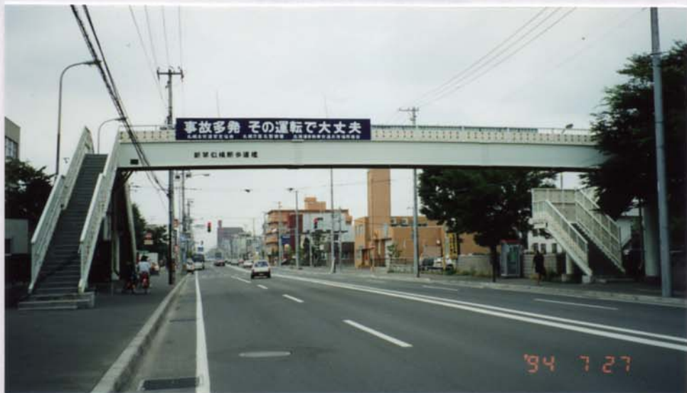
写真-5.8 新琴似歩道橋
