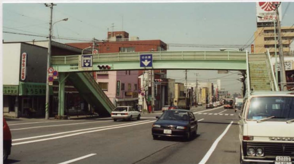
写真-5.3 月寒歩道橋
