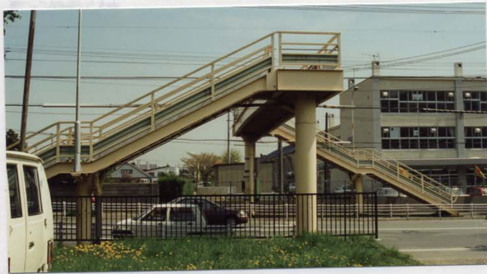
写真-5.1 山の手小学校前歩道橋
