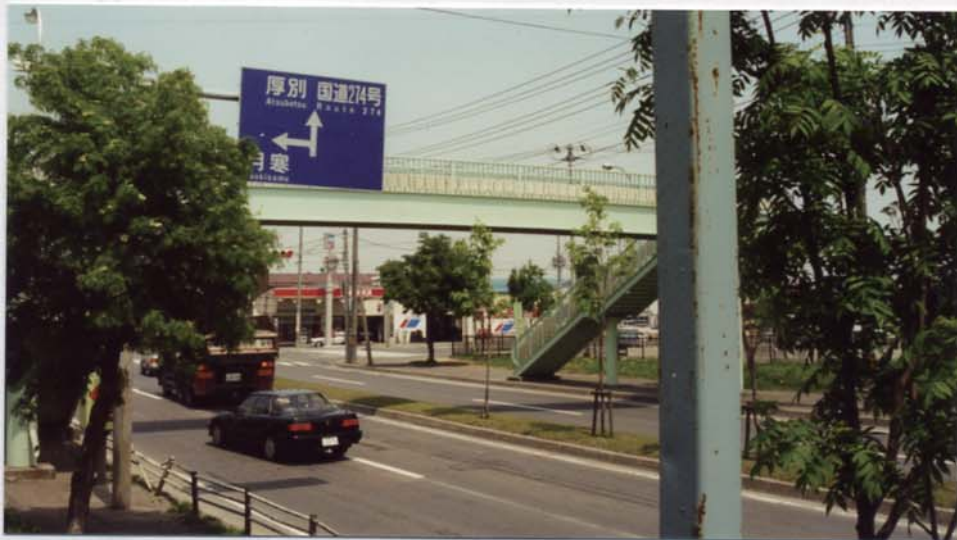
写真-5.5 平岡歩道橋
