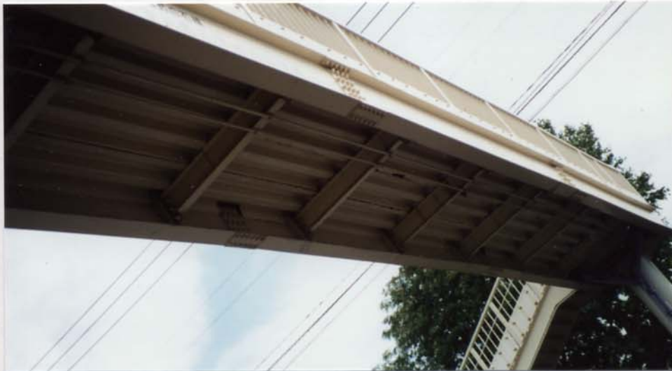
写真-5.2 宮の森小学校前歩道橋
