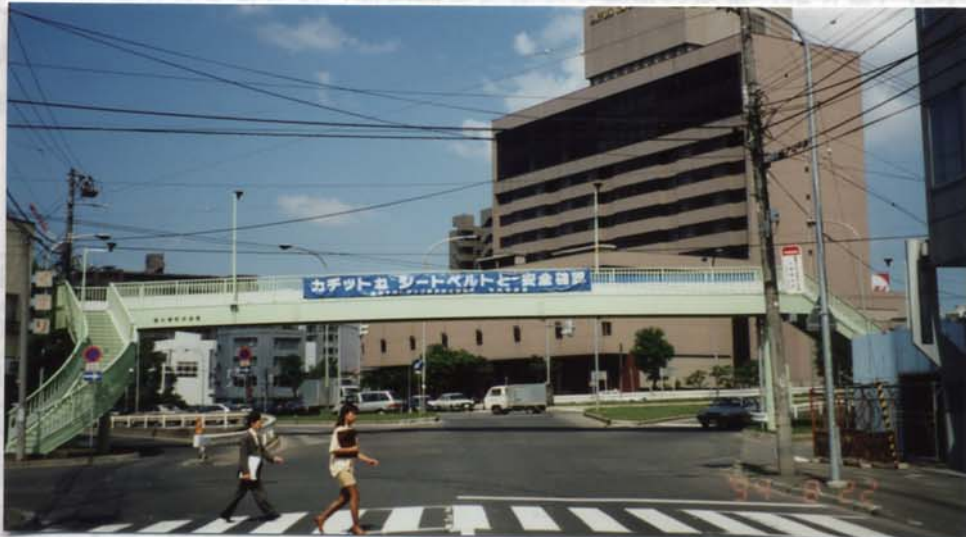
写真-2.3 豊水歩道橋
