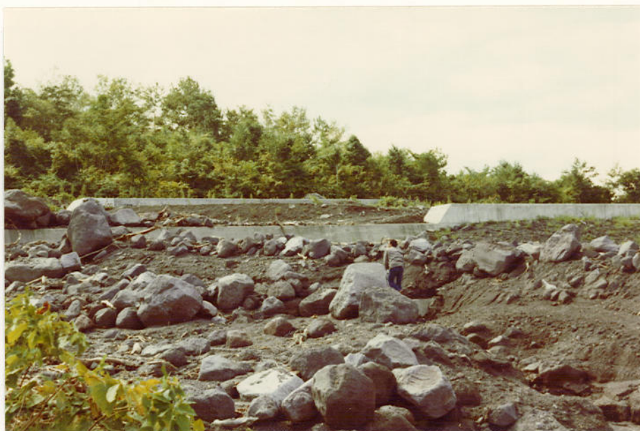
Photo-5 床固工群による石流の分散堆積。 堆積地の中央部に流路が形成された。 (青木沢扇状地・堆積A)。
