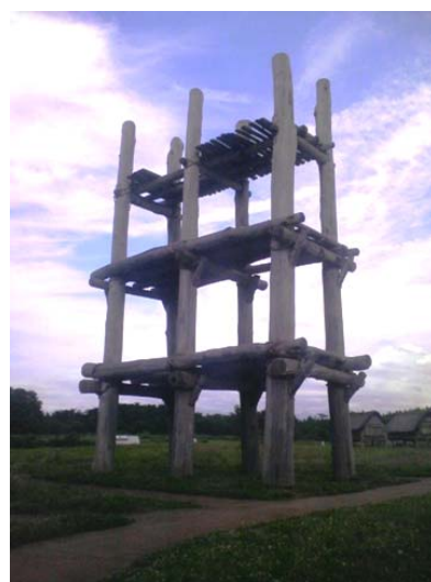
図 4-3 三内丸山遺跡の復元された大型掘立柱建物
