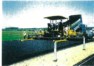
写真-6 写真-5撮影時のフィニッシャーおよび混合物運搬用トラックの施工状況
