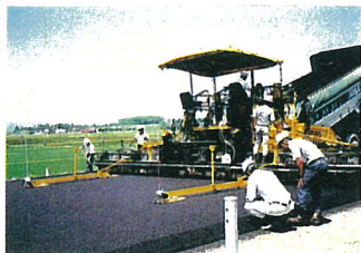
写真-8 写真-7撮影時のA社のフィニッシャーの施工状況
