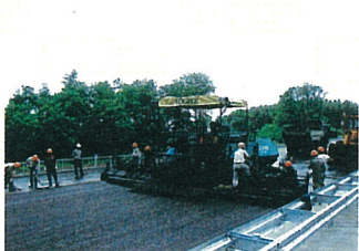
写真-10 写真-9撮影時のB社のフィニッシャーの施工状況
