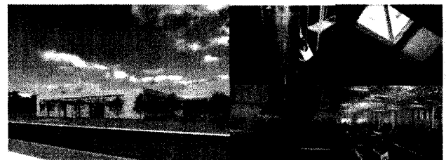
写真-1 新工場外観・吹出・還気・排気口・内部
