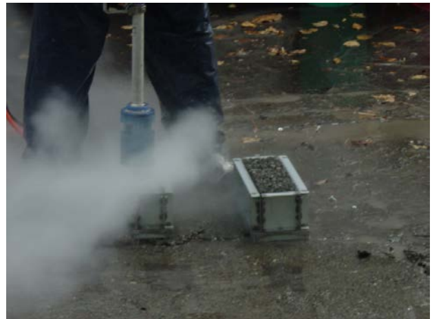
写真 2.2 ウォータージェット施工（2）
