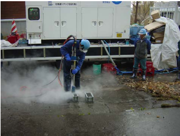
写真 2.1 ウォータージェット施工（1）
