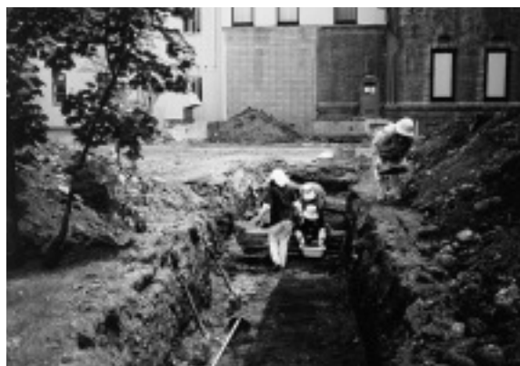
5. I 区調査状況（北より）
