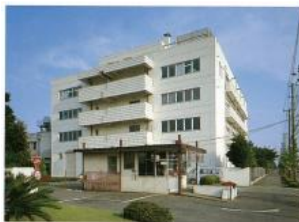
オイレスTC棟 RC造5階建、延床面積4786㎡、LRB31基・RB4基
