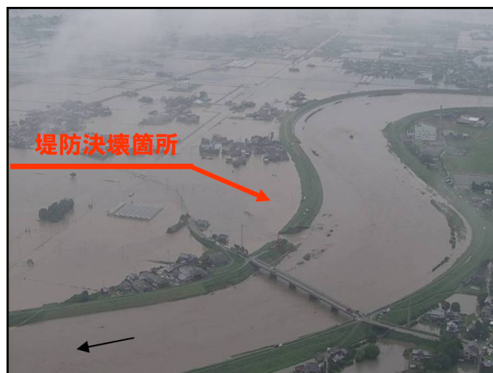
図-1.2 矢部川六合地区（H24.7） （2012.7.13～14 筑後川・矢部川・喜瀬川流域の状況について（速報）より）
