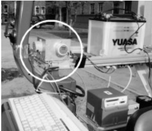
図 3.4 傾斜計とその配置
