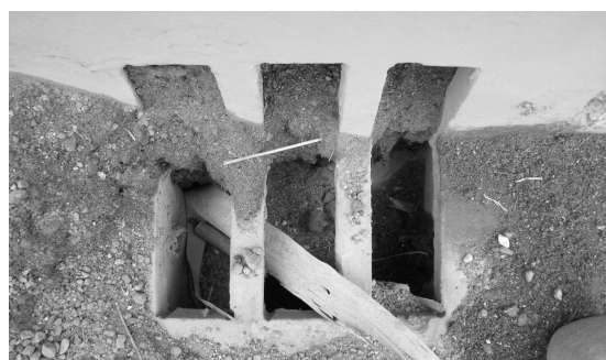
写真-6.4.4 B橋の排水マスの状況 (塗布5年後の3月に撮影)
