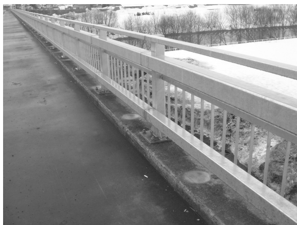
写真-7.3.1 高欄取り替え後の状況（北海道内の道路橋）
