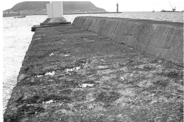
写真-1.2.2 スケーリング被害（防波堤天端）
