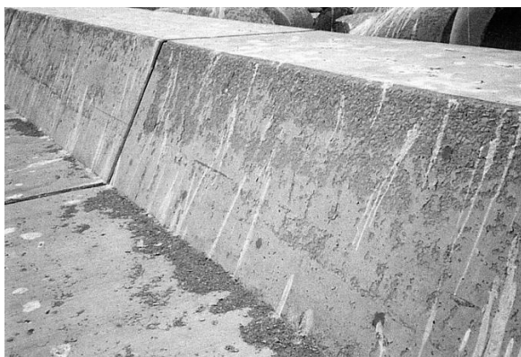
写真-1.2.1 スケーリング被害（防波堤斜面）
