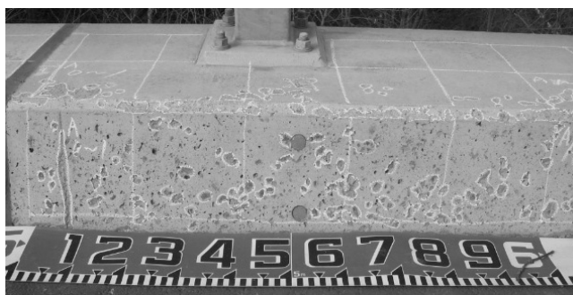
写真-6.4.1 塗布前の C 橋地覆の状況
