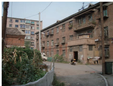
写真 2-4-2 奉天の満鉄社宅その 2 (2011 年撮影) 写真は瀋陽の旧・皇姑屯機車修理工場の社宅で、工場敷地より北側に位置しているレンガ造の 3 建ての集合住宅である。
