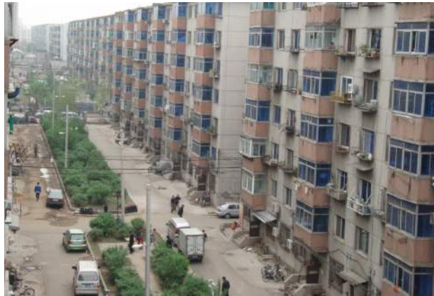
写真 5-5-1 社宅団地の建物の外観 その1 (2011. 9) 写真の中は、更新された社宅団地の外観である。7階建ての集合住宅住棟で、バルコニーの青いガラスサッシが目立つで、ほとんどのバルコニーはガラスサッシを設置している。住棟間には、緑地が設けられ、その緑地の周囲で車が駐車している。
