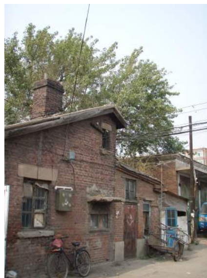
写真 3-5-6 奉天の旧満鉄社宅 その6 (2011年撮影) この社宅は皇姑区にある皇姑屯駅北側に位置する。建物はレンガ造の2階建てのテラスハウスである。各住宅の独立した厨房とトイレが整備されている。
