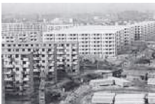
写真 3-6-3 1990年代「安居プロジェクト」住宅
