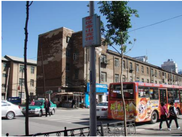
写真 3-5-1 奉天の旧満鉄社宅 その1 (2011年撮影) この社宅は和平区にある瀋陽駅の東北側に位置する。建物はレンガ造の3階建ての集合住宅である。各住宅に独立した厨房とトイレが整備されている。
