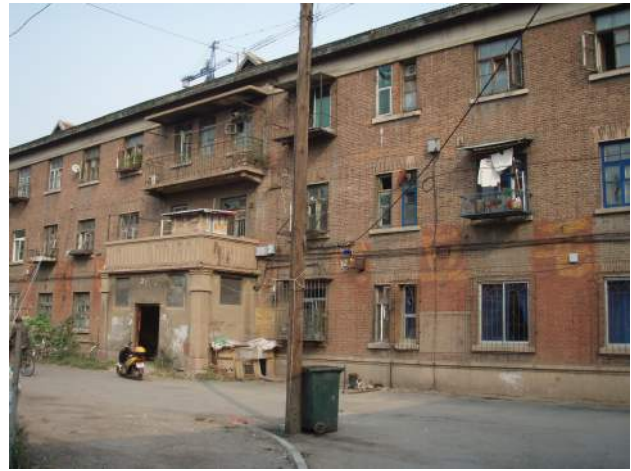
写真 3-5-2 奉天の旧満鉄社宅 その2 (2011年撮影) この社宅は皇姑区にある皇姑屯駅北側に位置する。建物はレンガ造の3階建ての集合住宅である。共用住宅であり、各階に共用の厨房とトイレが2箇所に整備されている。
