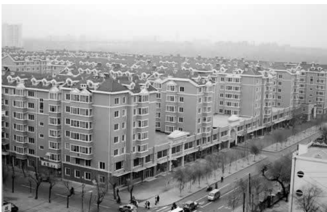
写真2-4-4「鉄西工人村」の住棟（撮影者：劉放） 写真は劉放撮影、劉放・王健著「瀋陽：工人村の変遷」、中国檔案、2008.1、より転載したものである。写真は、工人村の住宅団地が建替えられた後の様子である。団地は複数の7階建て集合住宅から構成されている。
