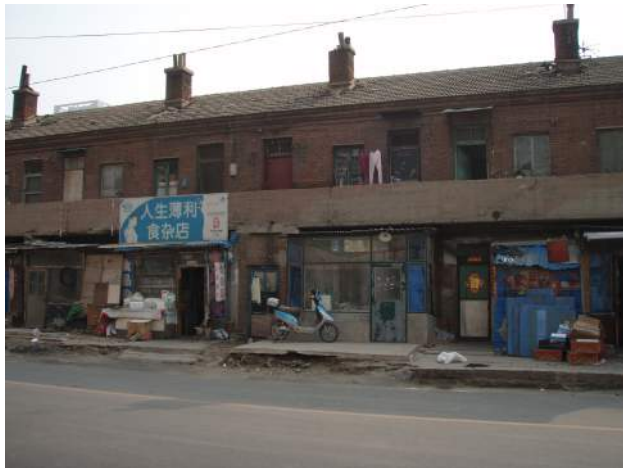
写真 3-5-3 奉天の旧満鉄社宅 その3 (2011年撮影) この社宅は皇姑区にある皇姑屯駅北側に位置する。建物はレンガ造の2階建ての集合住宅である。建物は外廊下式で、各住宅に独立した厨房とトイレが整備されている。
