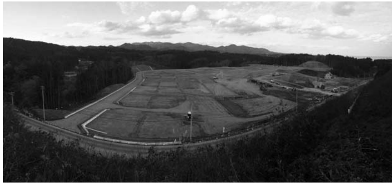
写真①/小泉地区の造成工事の様子(2014年11月16日撮影)。
