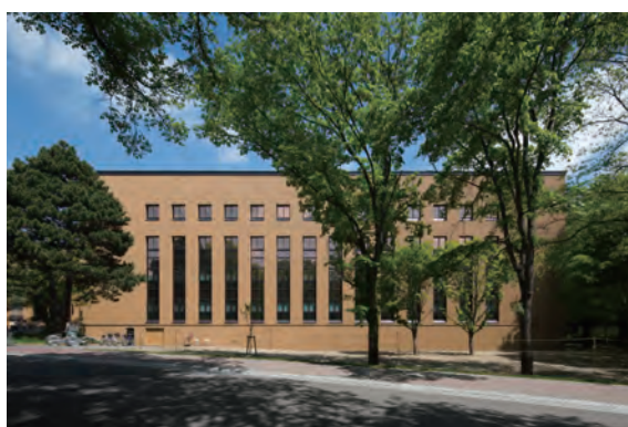
新棟（南棟）の外観
