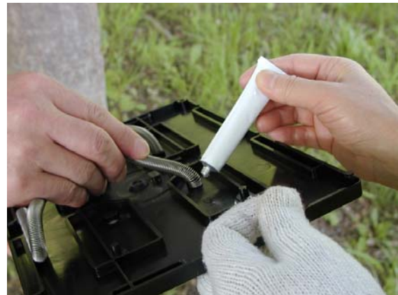
図2. 看板の取り付け作業
