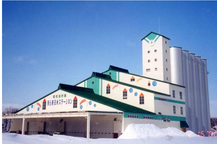
写真 11 栗沢町, 超低温貯蔵 未来来る米ステーション, 1999 年建設, 粳貯蔵能力 3900 t
