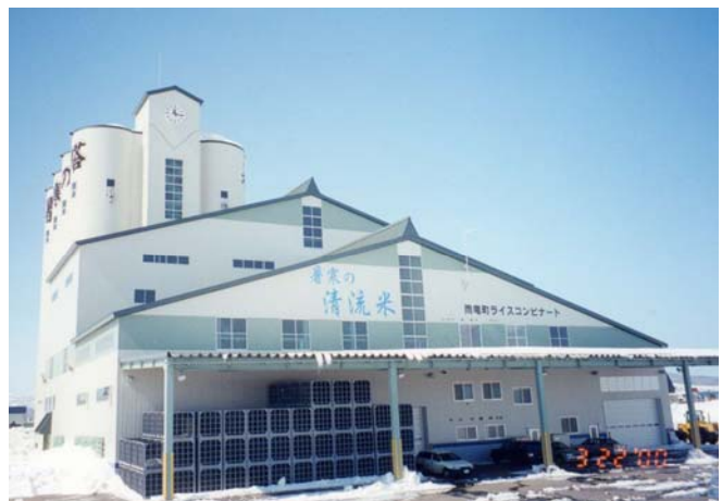
写真 9 雨竜町カントリーエレベータ
