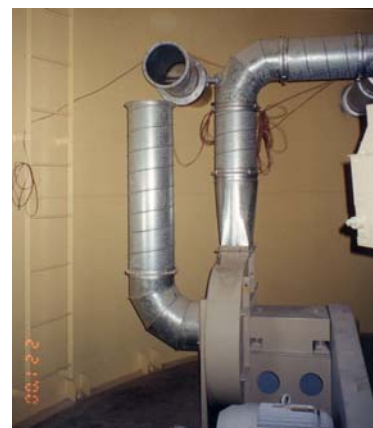
写真7 通風空気取入口の変更後の様子（変更前の写真3を参照）
