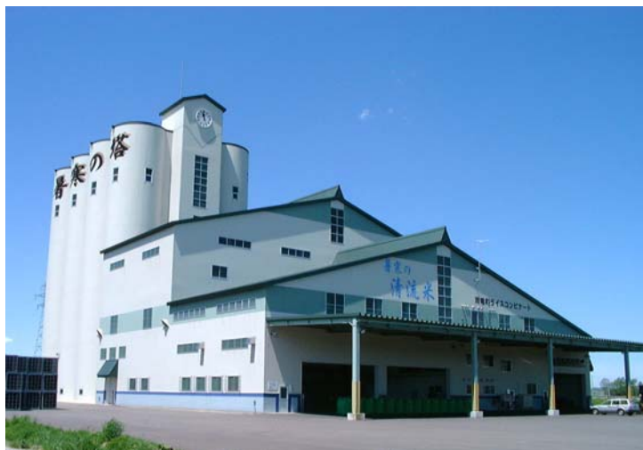
写真1 雨竜町カントリーエレベータの外観
