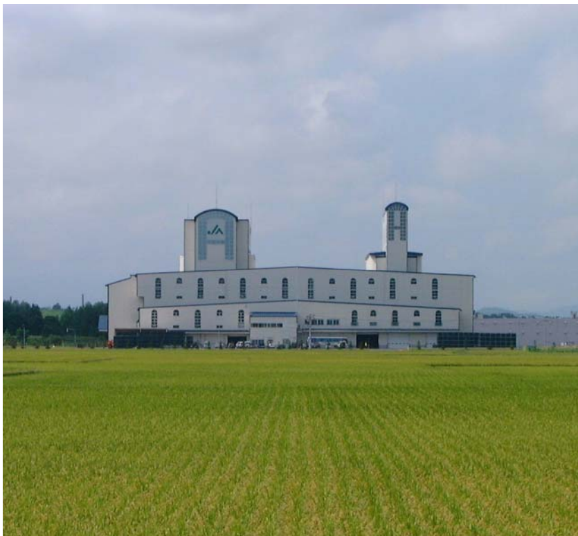
写真 10 鷹栖町，上川中央部米穀広域集出荷施設（上川ライスターミナル）
