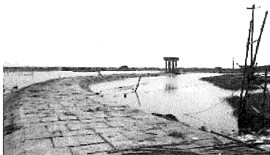
写真-2 フン川河口のタオロン堰
