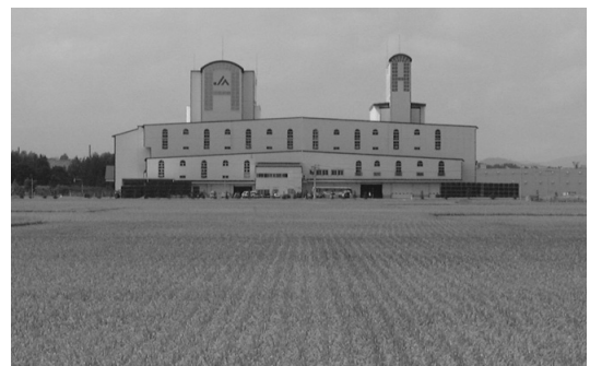
図2 米の共同乾燥調製貯蔵施設(カントリーエレベータ) 北海道上川ライスターミナル、計画初処理量：11,800t、籾貯蔵能力：10,000t。
