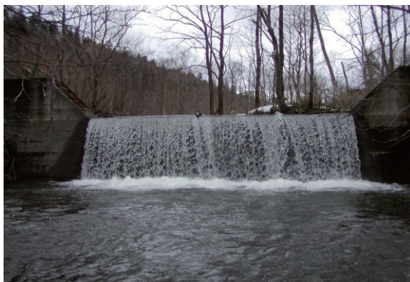
写真-10 放流点 No.1(治山ダム)風景
