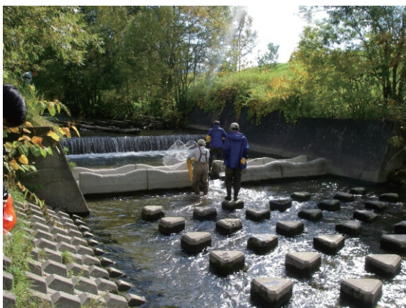
写真-16 落差工調査風景 (プール状に改変)
