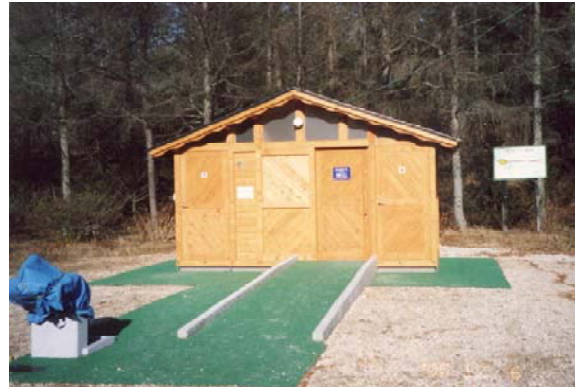
新設されたバイオトイレ
