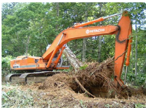
写真3 根の掘り取り作業(ダケカンバ)
