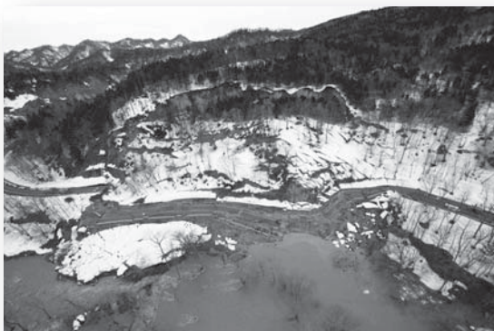
平成 24 年国道 239 号霧立峠（北海道開発局提供）
