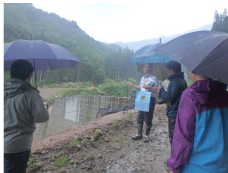
梨子沢第3砂防堰堤
