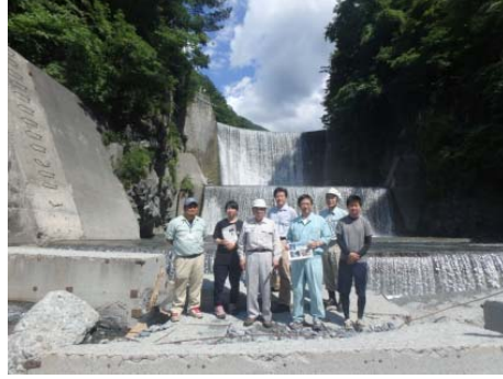
上蔵(わぞ)砂防堰堤
