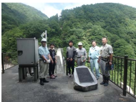
飯島第6砂防堰堤
