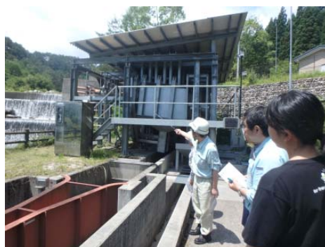
坊主平砂防堰堤・流砂観測施設
