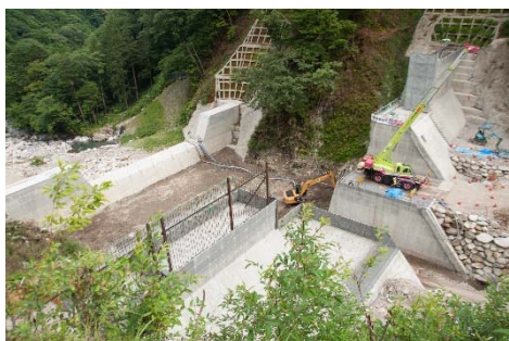
黒川第4砂防堰堤
