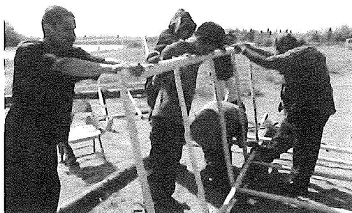
写真1 カゴの組み立て作業 (6月19日)
