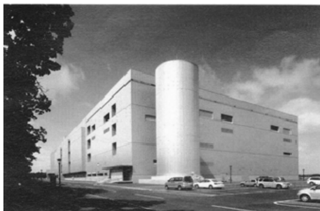
図 2.1 対象施設全景（正面円筒は縦型蓄熱槽）
