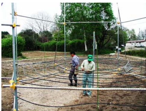
図1. 建設中のFACE（地面の白い部分は苫小牧研究林産の火山灰土壌）（上田氏提供）
