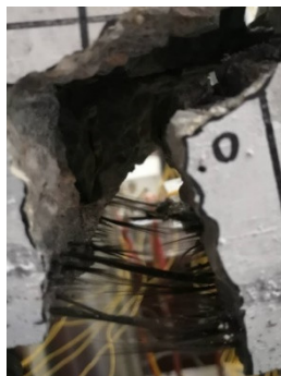
(d) Carbon-FRCM failure in C-B-L2-60
