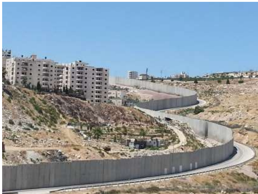
図 9 住宅地を囲むように建設されている分離壁
