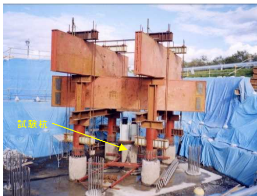
図 1.18 杭の鉛直載荷試験 34)
