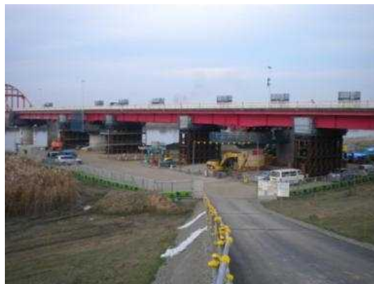
c) 仮設ベントによる仮復旧状況
