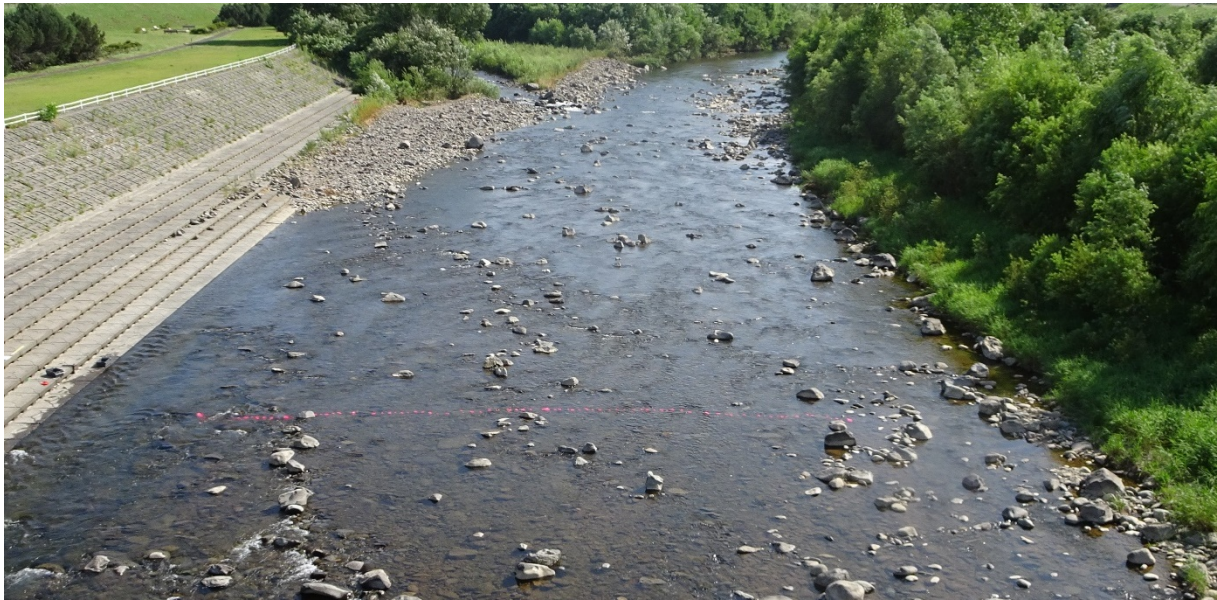
図 4.6 トレーサー材の設置状況
