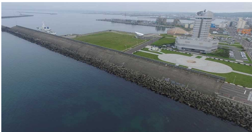
写真-3-2-1 稚内港北防波堤ドームの全景
