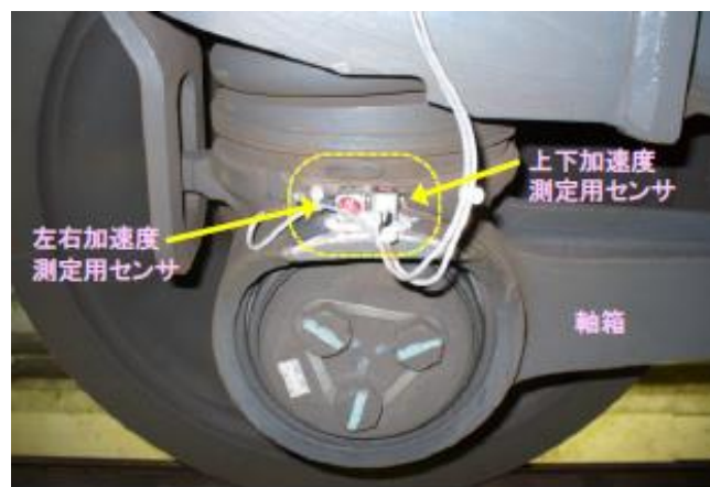
図 4-10 軸箱への加速度センサの設置状況
