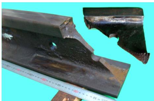
(a) 継目穴からのき裂による折損-1
