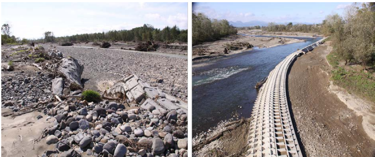
図 5-1 既設護岸の被災状況（北開水工コンサルタント撮影）
