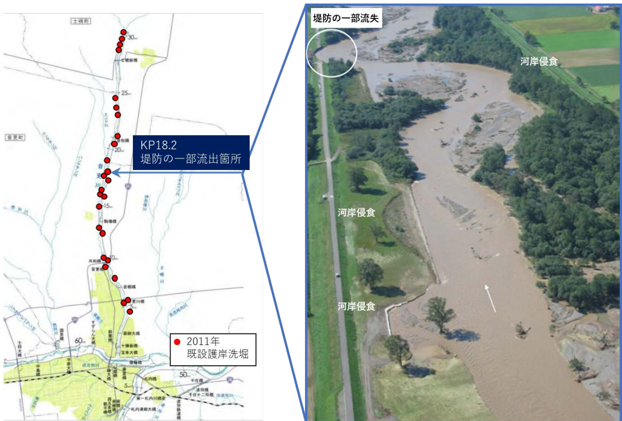
図2-3 2011年9月洪水による河岸侵食（侵食幅20m以上）の発生箇所（開発局提供）
