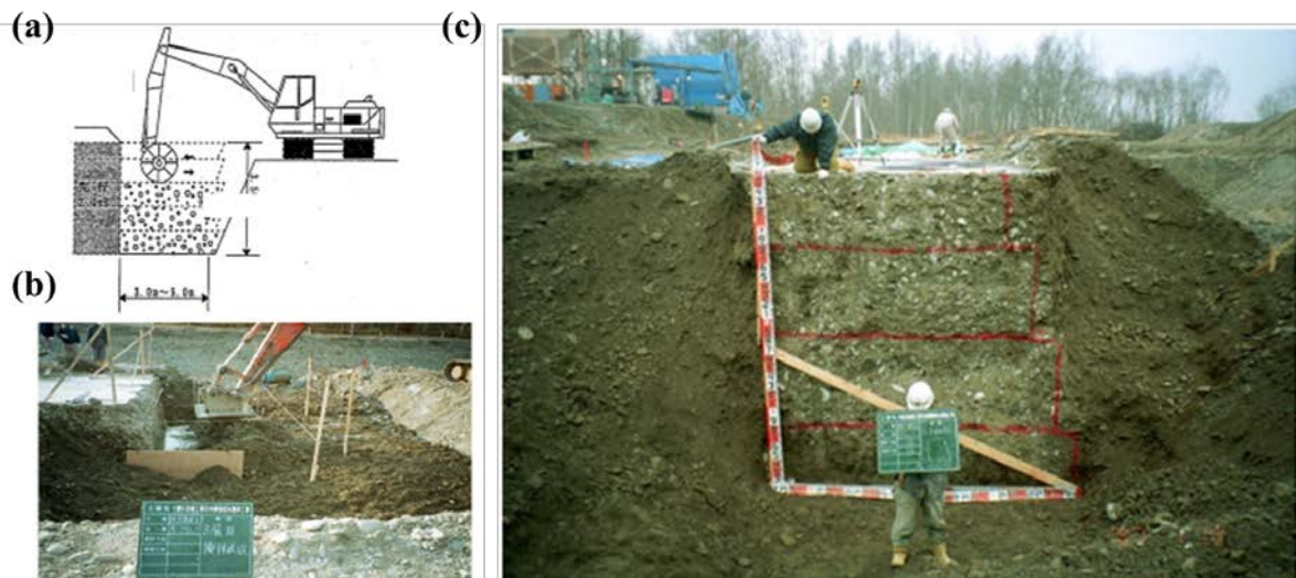
図6-5 十勝川水系札内川(KP12.6 右岸)における現地材料を活用したコンクリートウォールを用いた堤防基盤部分の侵食防護対策の試験工事
