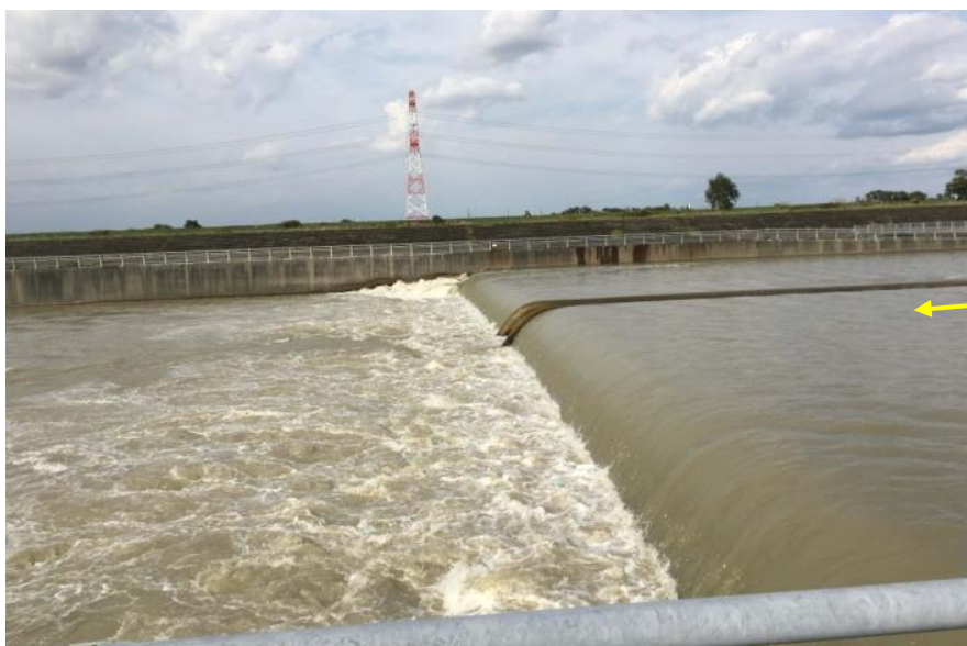
図 2-5 現在の清幌床止（2016年9月）
