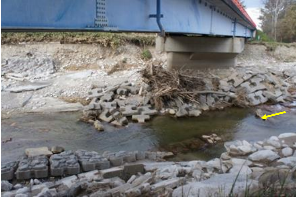
図 1-1 平成 28 年台風 10 号によって岩盤侵食が進行したペケレベツ川上流
