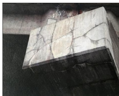
(b) 道路橋の橋脚
