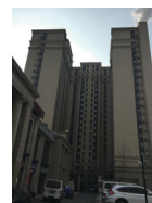
賃貸住棟の外観 (のち一棟)
