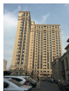
賃貸住棟の外観 (のち一棟)
