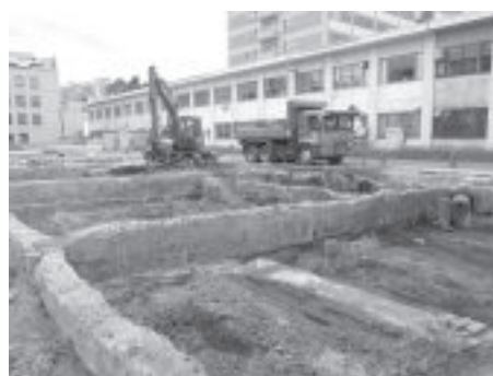
B. 表土はぎの様子(遠景:南東より)
