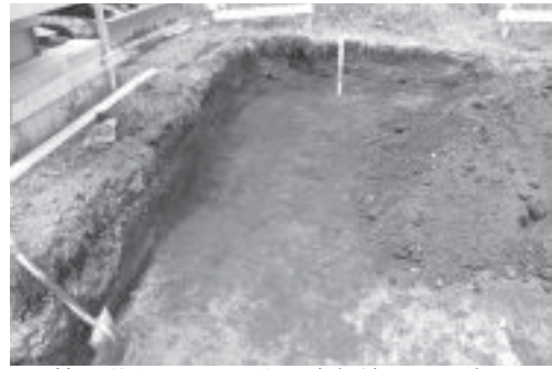
B. 情報基盤センター北側冷却棟設置工事 (北西より) 1807
